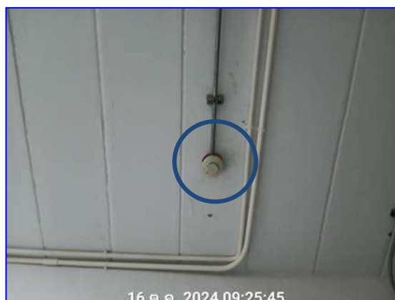
รูปที่ 2.11 ระบบตรวจจับควัน (Smoke Detector)
